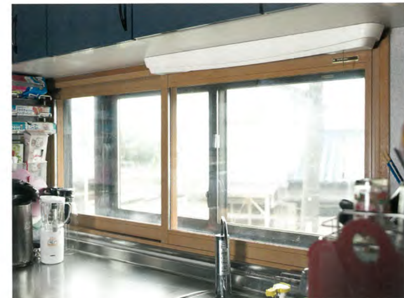
夏の暑さに悩んでいた西向きキッチンも、内窓のガラスを遮熱タイプにしたおかげで、すっかり快適に。
